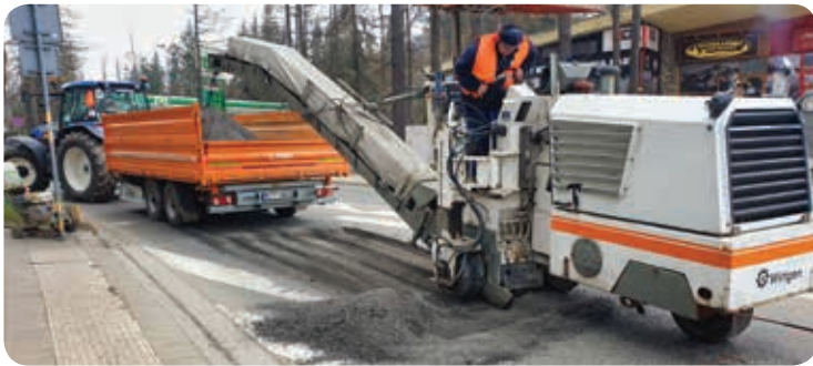
▶ Droga na Bystre – remont ubytków w jezdni
