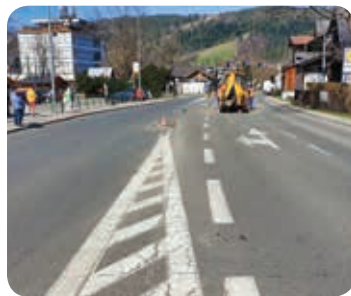
▶ Aleje 3 Maja – remont ubytków w jezdni
