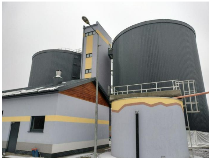
Fot. Wydzielone komory fermentacji
