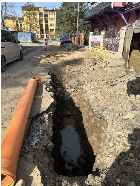
Fot. Budowa kanalizacji w ul. Szymony (Boczna)
