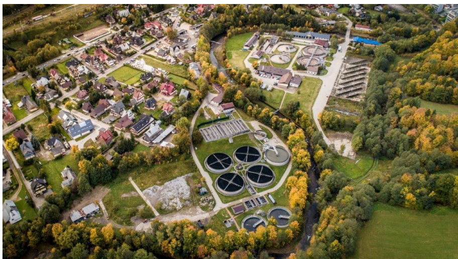
Fot. Oczyszczalnie ścieków Łęgi i Spyrkówka
