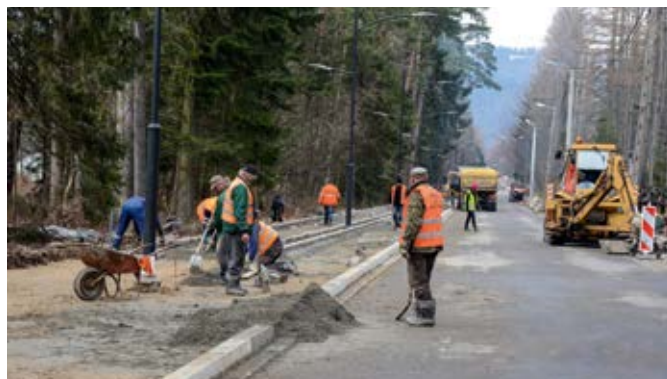
Przebudowa drogi ul. Przewodników Tatrzańskich – etap I
